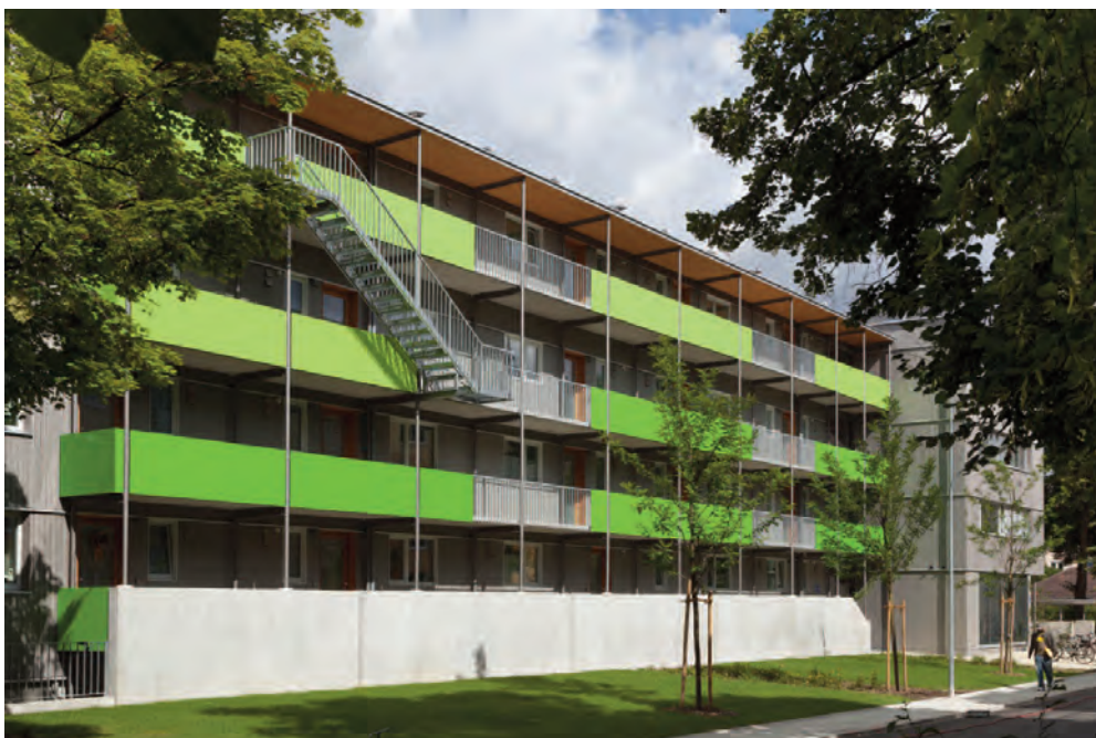
Fassade zur Badgasteiner Straße
